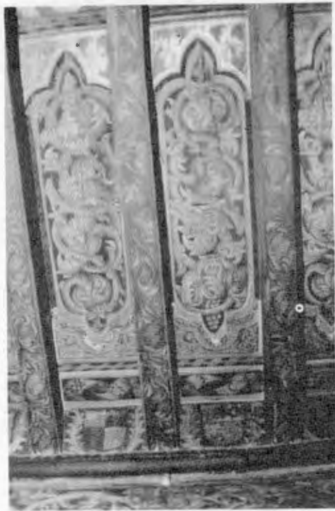
Fig. 1. — Detalle de la techumbre de la Casa de los Lanuza.
