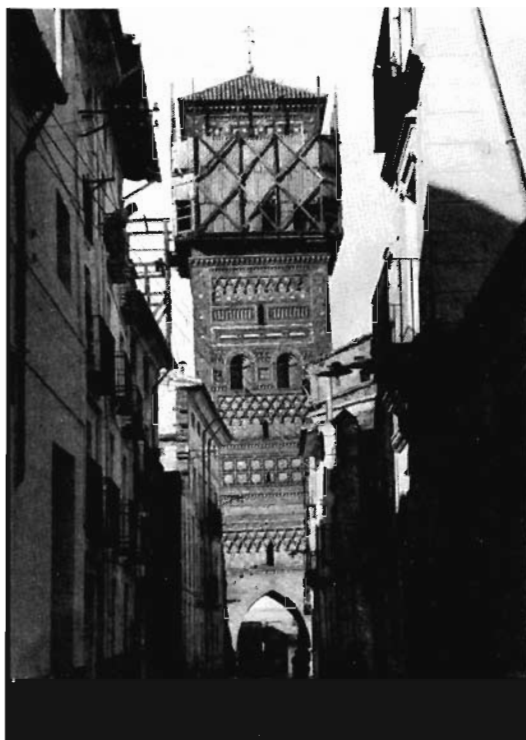
Torre de San Martín durante la restauración de 1932
