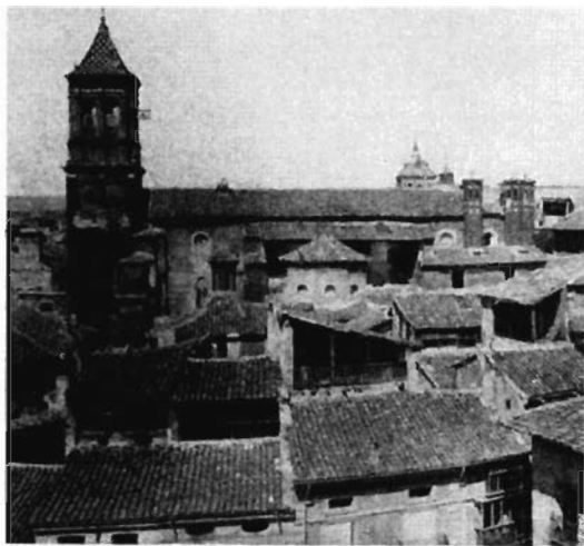
Torre de San Pedro antes de la restauración
