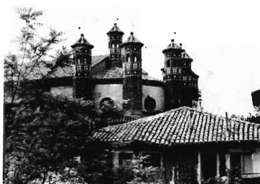
Torreoncillos del ábside de la iglesia de San Pedro en Teruel
