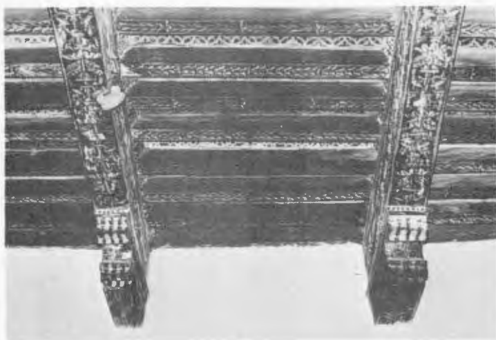
Fig. 2.— Alfarje de la Sala Capitular del Monasterio de San Clemente de Toledo. Decoración pintada, con algunos elementos de tradición gótica —traceras— y predominio de los grotoscos a condelieri. Comienzos del siglo XVI.
