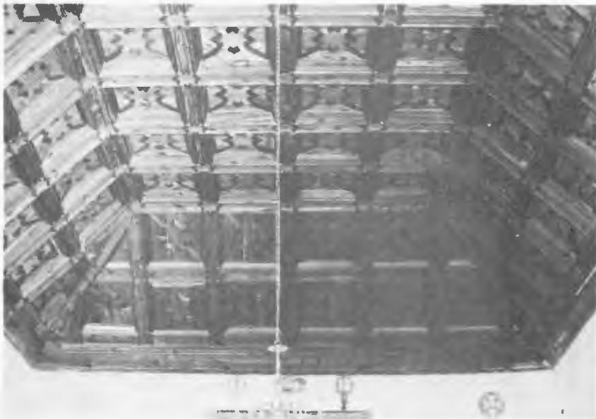
Fig. 2.— Armadura de la Sala Capitular del Monasterio de Santo Domingo el Antiguo, de Toledo, de estilo morisco-renaciente. Perfil morisco de armadura de limabordón, con amplio almizate, y artesones o casetones de influencia renaciente. Comienzos del siglo XVI.
