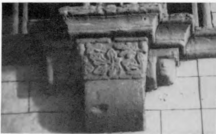
Figura 6.—Ménsula con decoración vegetal flanqueada por atlantes.
