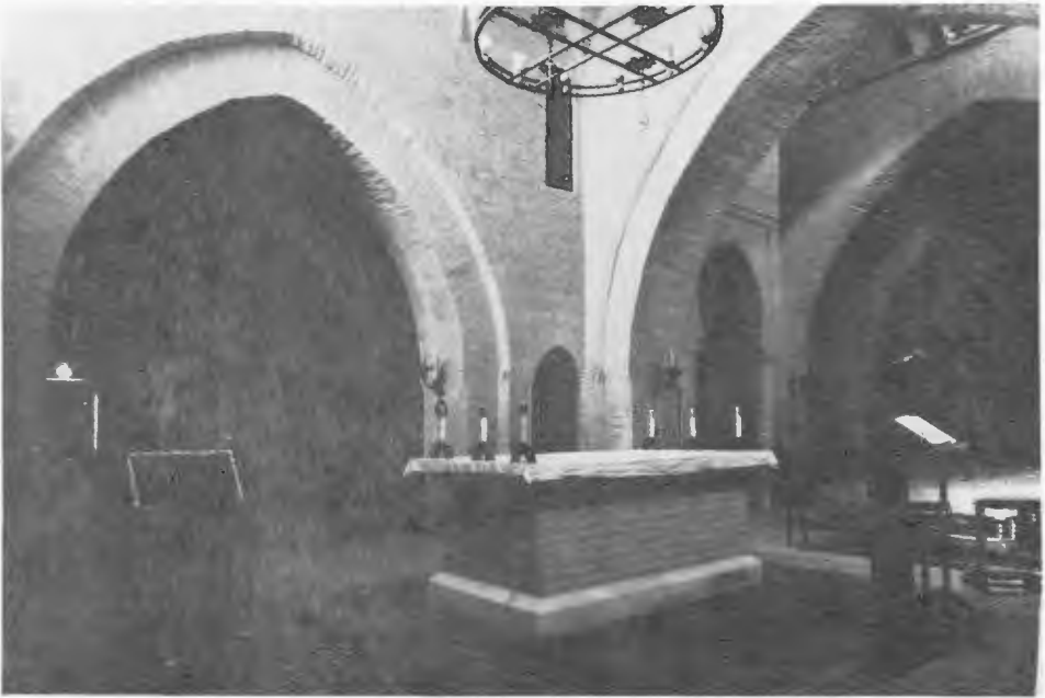
Figura 6.—Vértice de las dos naves. Espacio unificador.
