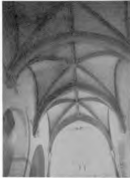
Figura 8.—Bóveda de la nave central de la iglesia.
