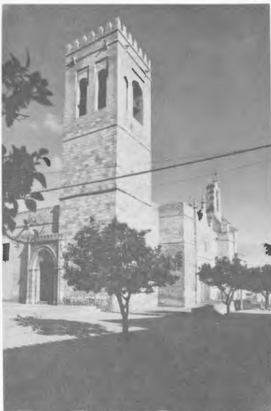
Figura 8.—Alminar y campanario. Verticalidad.
