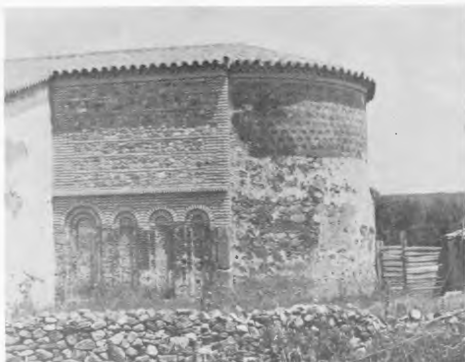
Figura 5.—San Pedro de Aroche. Lateral Sur del ábside.
