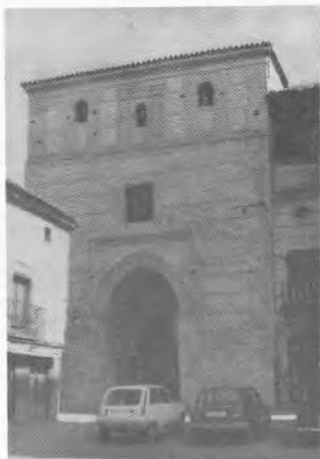
Figura 5.—Arco de la cárcel. Arevalo.
