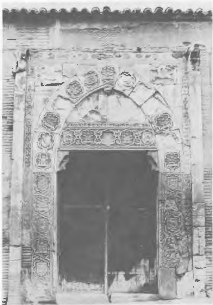
Figura 4.—Portada del antiguo palacio de los Toledo y Ayala (1374-1385); desde fines del siglo xv, convento de Sta. Isabel de los Reyes.
