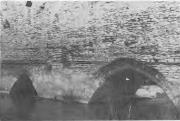
Figura 3.—Puente de Valladolid. Arévalo.
