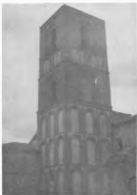
Figura 7.—Torre de los queareces. Iglesia de San Martín Arévalo.
