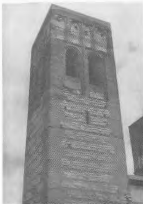
Figura 8.—Torre del hastial. Iglesia de San Martín. Arévalo.
