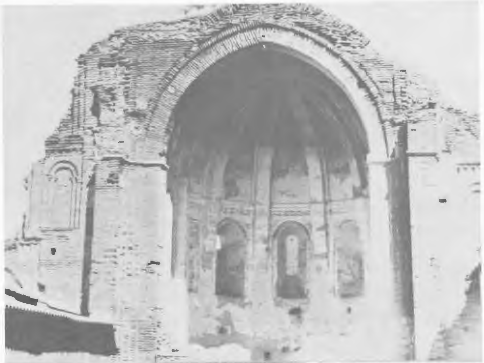
Figura 22.—Santa María de la Vega. Interior del ábside.
