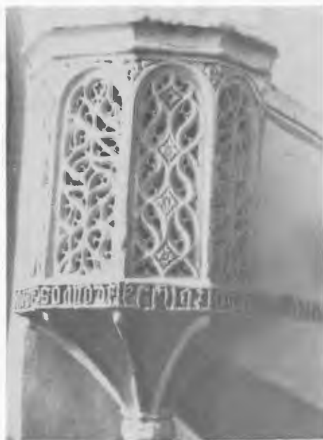
Figura 16.—Torre Murte. Púlpito de la Ermita.
