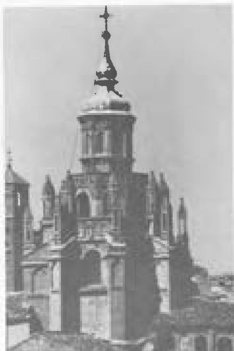
Figura 1.—Cimborrio de la Catedral de Tarazona, exterior.
