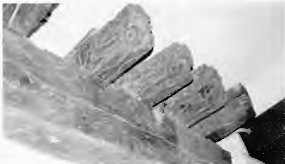
Fig. 13. Santa Clara de Carrión de los Condes. Canes de madera de la primitiva techumbre mudéjar. Fines del siglo XIII.
