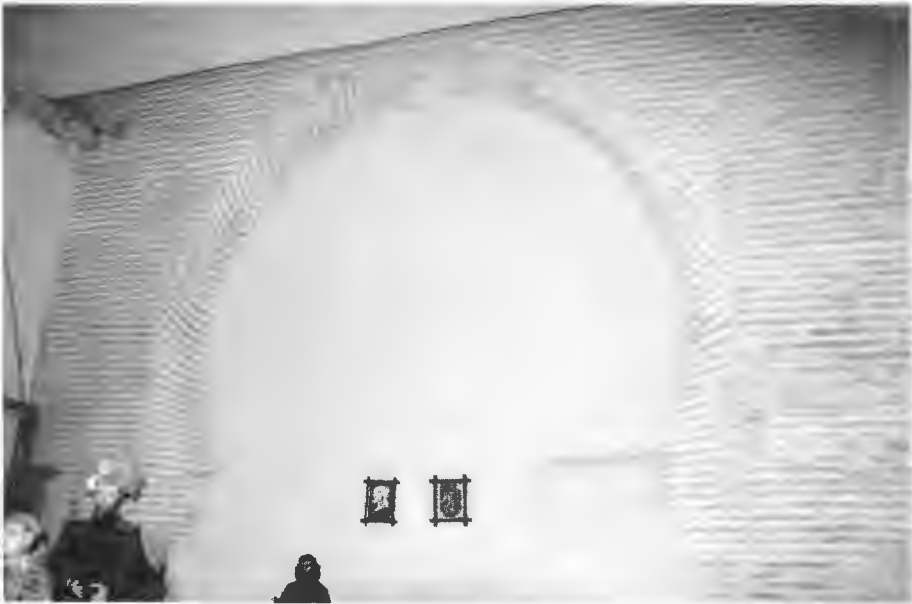
Fig. 6. Santa Clara de Tordesillas. Arco de ladrillo de herradura apuntada de acceso a una de las alcobas, existente en el lado este del patio y correspondiente al palacio de Pedro I. Mediados del siglo XIV.
