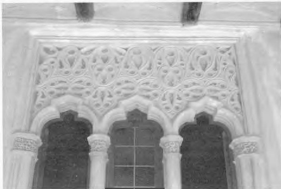
Fig. 11. Ventanas, palacio de los Reyes Católicos. Aljafería de Zaragoza
