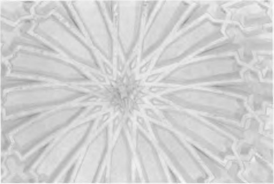
Fig. 5. Tordesillas. Monasterio de Santa Clara. Capilla Dorada. Bóveda de albañilería y yeso. Medios del siglo XIV
