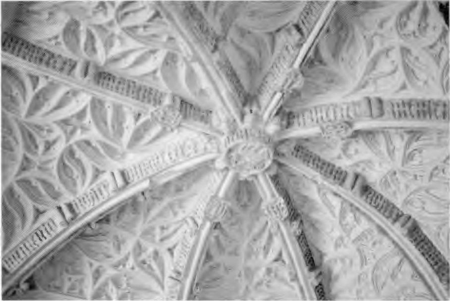
Fig. 11. Burgos. Monasterio de las Huelgas. Angulo en el claustro de San Fernando. Bóvedas de yeso. Medios del siglo XV
