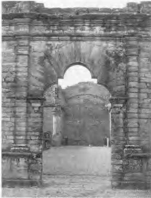
Fig. 2. Perfil mixtilíneo, arco de la fachada de la iglesia de Jesús (Provincia Jesuítica del Paraguay).
