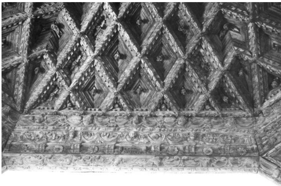
Fig. 4. Capilla de la Visitación de Salas de los Barrios (León). Detalle de la decoración del arrocabe y artesones.
