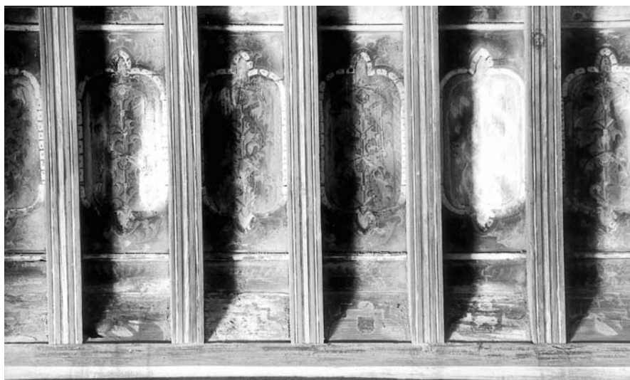
Fig. 7. Iglesia de San Andrés. Aguilar de Campos. Cubierta de la nave principal y detalle de las tabicas, con los escudos de los Enriquez, Mendoza y Ayala.
