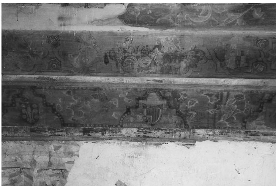
Fig. 11. Iglesia de San Miguel. Villalón de Campos. Detalle del doble alicer de la armadura con decoración heráldica.
