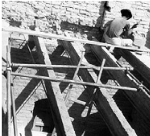
Lám. 9. Desmante del forjado de hormigón armado realizado por Félix Hernández al reconstruir la azotea que cubría la bóveda (fot. Archivo de los arquitectos técnicos José María Becerra Romana y Gonzalo Cátedra Cátedra, hacia 1970).
