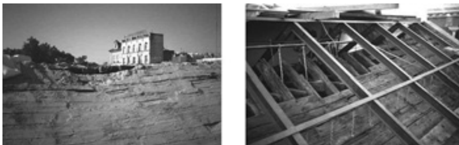
Lám. 15. Estado de la cubrera previo a la intervención de 1991 y ejecución durante la misma de la estructura metálica de la cubierta (fots. J.L. Barón Cano, 1991 y 1992).
