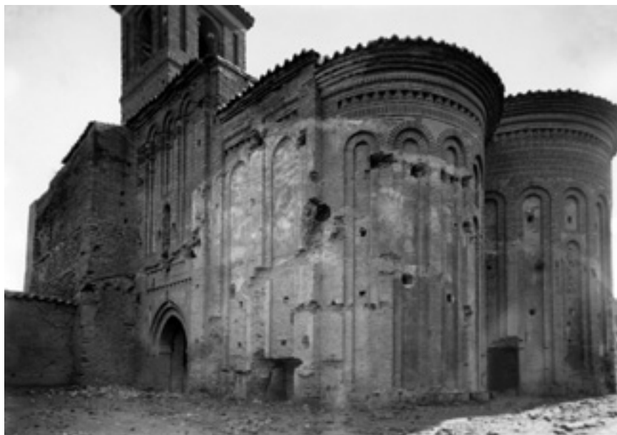
Fig. 7. Iglesia de San Salvador de los Caballeros, Zamora. Exterior durante las obras de restauración de Alejandro Ferrant. Archivo del Colegio de Arquitectos de Cataluña, Demarcación de Lérida.
