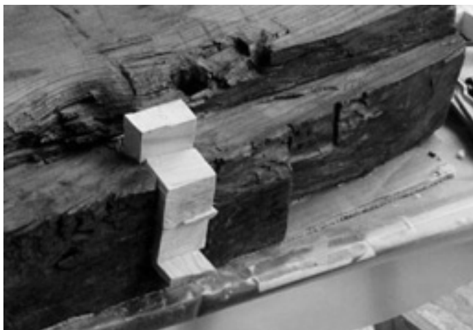
Imagen 17. Consolidación con madera de una de las zapatas (fot. M a Luisa Quirós).
