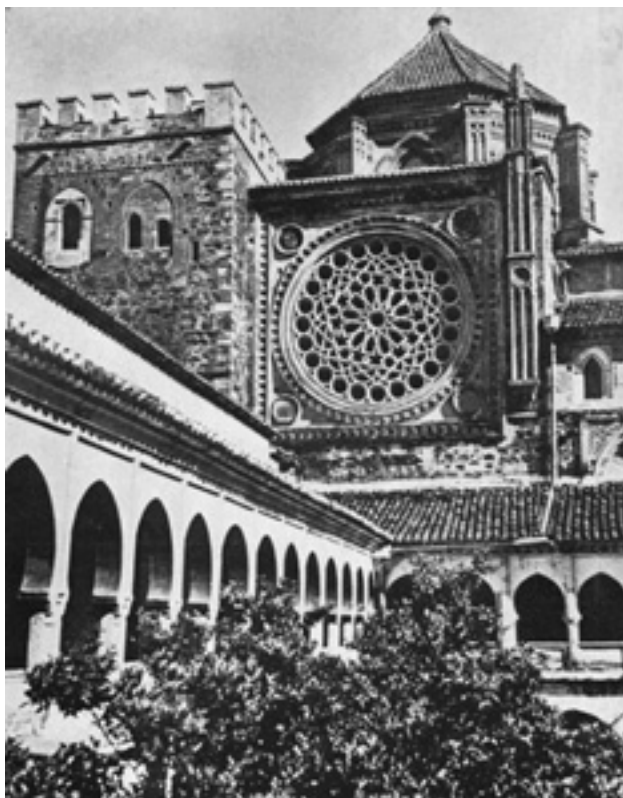
Fig. 8. El monasterio de Guadalupe, restauración del rosetón meridional, ya restaurado.
