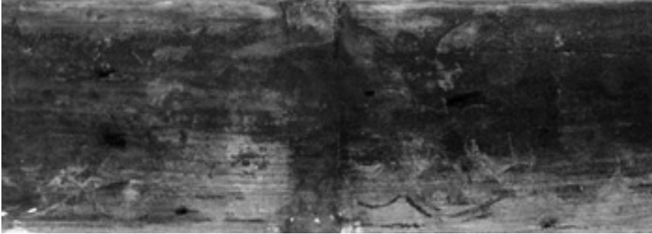
Imagen 11. Costado de la jácena sin repinte (fot. Tulia Sáez).
