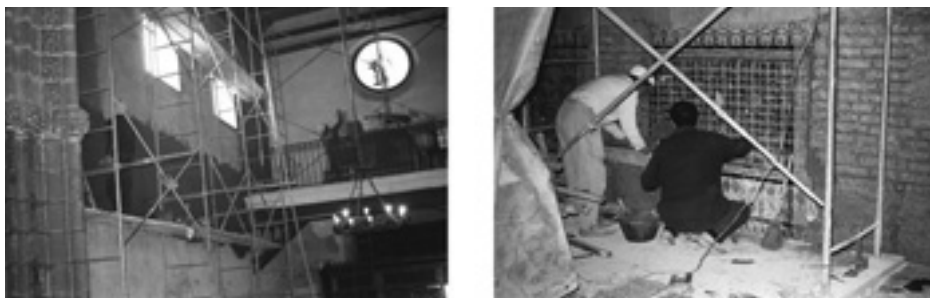
Lám. 14. Interior de la capilla durante la intervención de Rafael Manzano. Vistas del coro alto, que aún existía, y de la restauración de azulejos (fots. Archivo de J.M. Becerra Romana y G. Cátedra Cátedra, 1971).
