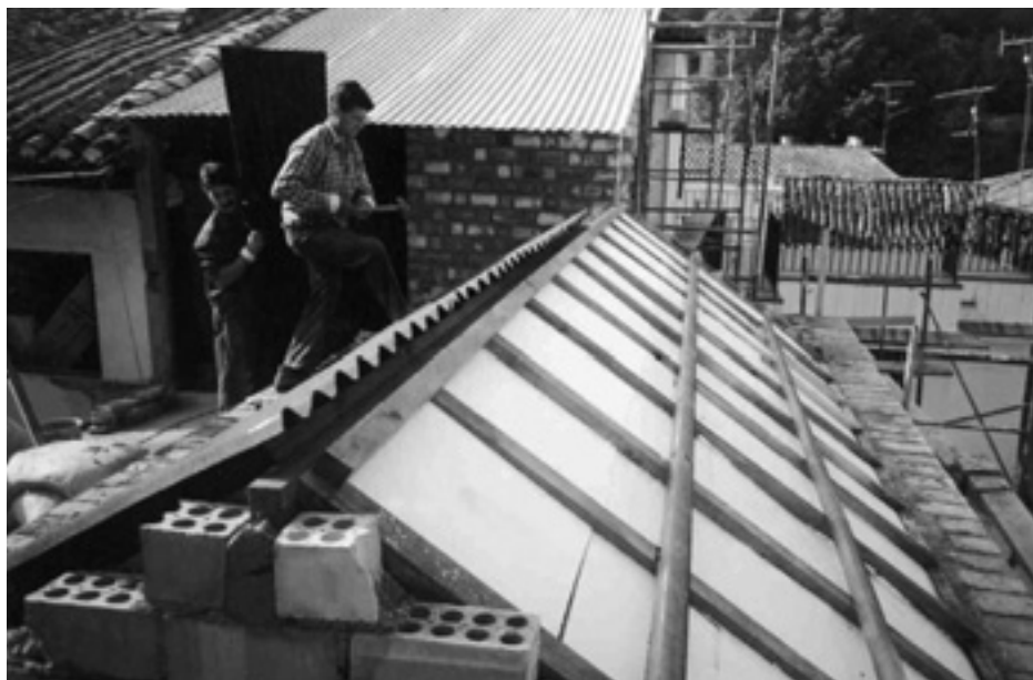
Foto 4. Cuesta de la Victoria nº 9. Recuperación de la cubierta.
