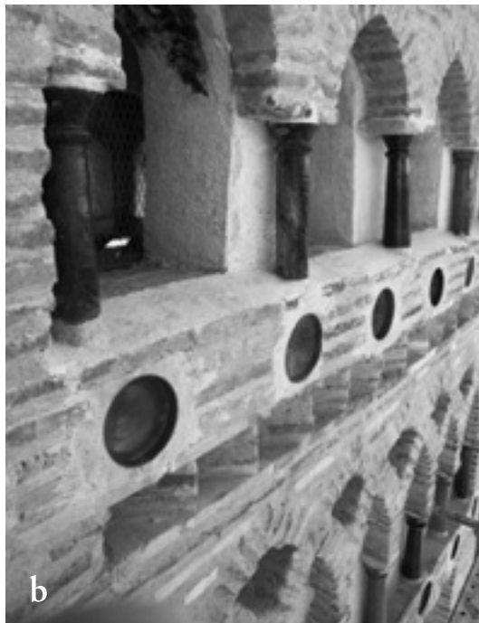
Fig. 13. Detalle de la arquería superior de la fachada suroeste: a) en su estado posterior a la primera fase; b) tras la segunda fase de restauración.
