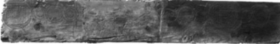
Imagen 22b. Zapata doble tras la intervención (fot. Tulia Sáez).
