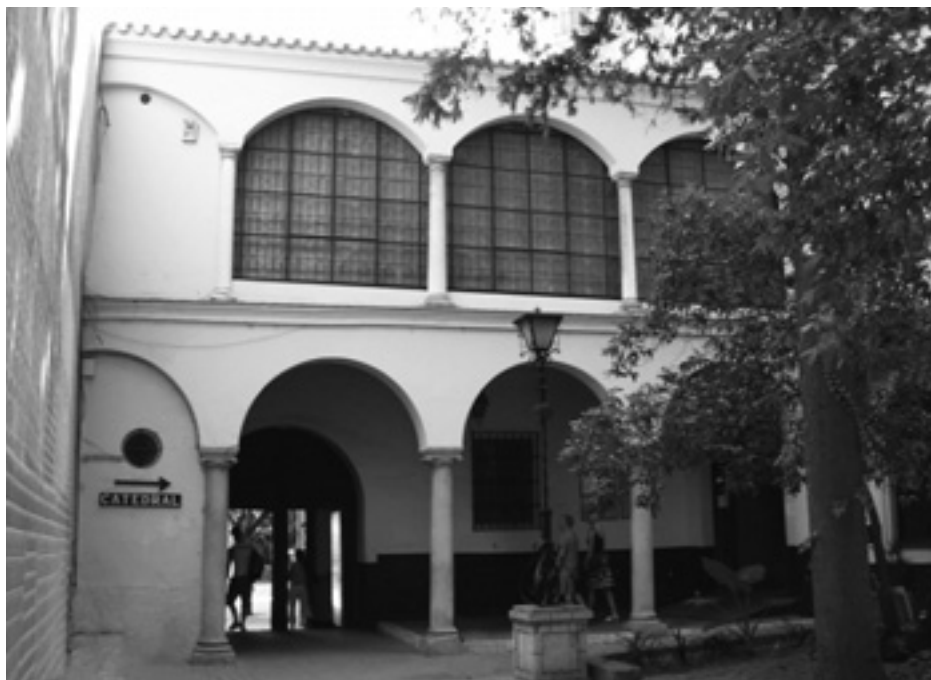
Fig. 1B. Pórtico del patio del Sagrario: estado actual.
