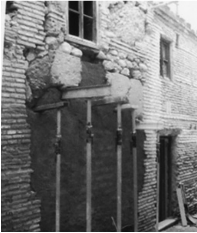
Foto 1. Vivienda en c/ San Buenaventura nº 2. Actuación en tapial.
