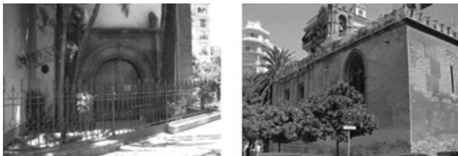
Lám. 16. Estado previo de la capilla antes de la intervención de 2005-2006. Vistas del atrio de entrada de la capilla y de las fachadas (fot. C. Sánchez Mendoza, 2005).
