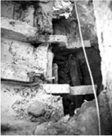
Lám. 7. Elementos metálicos de consolidación estructural que, presumiblemente, se colocaron en la intervención de Félix Hernández para sustituir la unión par-tirante en algunas zonas de la cubierta (fot. J.L. Barón Cano, 1991).
