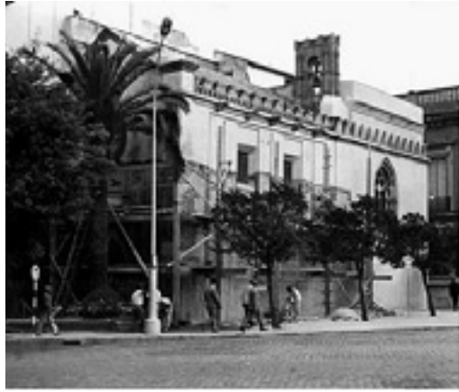
Lám. 8. Obras de saneado y reparación de revestimientos de la capilla efectuadas a finales de los años 50, según proyecto de Félix Hernández (Fototeca Municipal de Sevilla, Archivo Cubiles).
