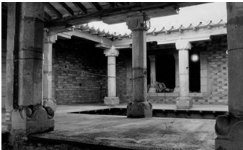
Imagen 3. Planta superior durante el proceso de restauración arquitectónica (Archivo General de la Administración).
