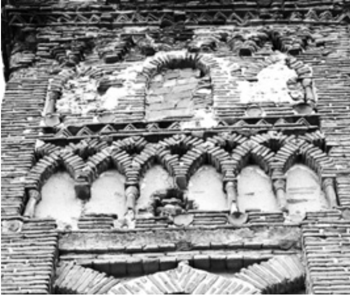
Fig. 6. Detalle de la conservación del friso y la arquería superior. Fachada noreste.
