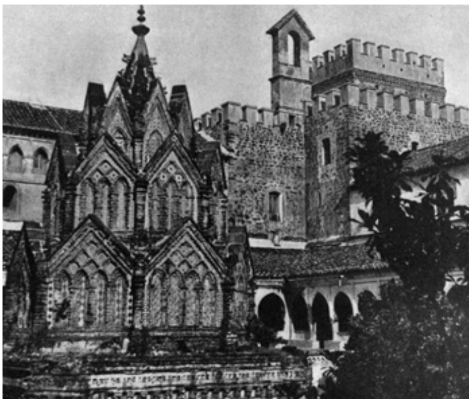
Fig. 6. El monasterio de Guadalupe, templete mudéjar y torre de San Gregorio, tras la restauración.
