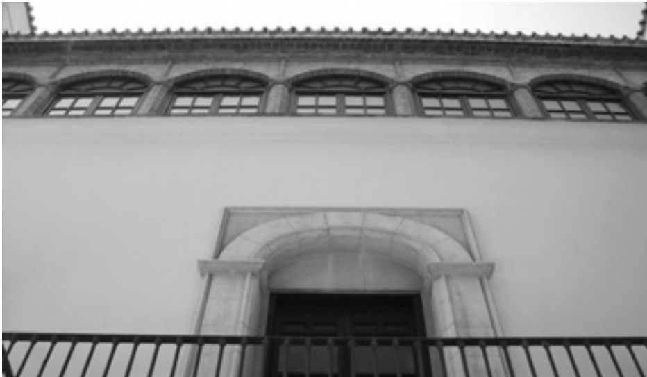
Fig. 5B. Palacio episcopal (palacio mudéjar): estado actual.
