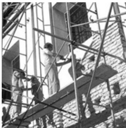
Lám. 11. Picado de revestimientos y saneado de la fábrica en la intervención de Rafael Manzano Martos (fot. Archivo de J.M. Becerra Romana y G. Cátedra Cátedra, hacia 1970).
