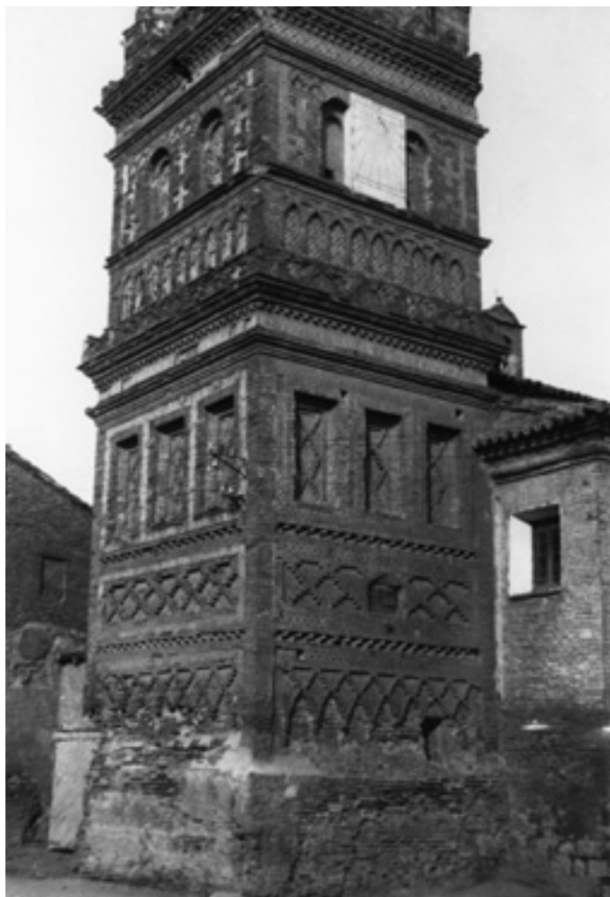
Fig. 3. Detalle del estado de conservación de la torre mudéjar de la iglesia de Utebo (Zaragoza). Es una de las diversas fotografías que acompañaban al informe del arquitecto Teodoro Ríos Balaguer, 1933. Archivo General de la Administración.
