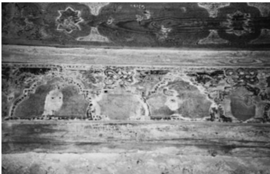
Foto 12. CASTROJERIZ (Burgos): iglesia de San Juan. Detalle del doble alicer de la armadura mixta de parhilería y limabordón de las galerías este y sur del claustro. Comienzos del siglo XV.
