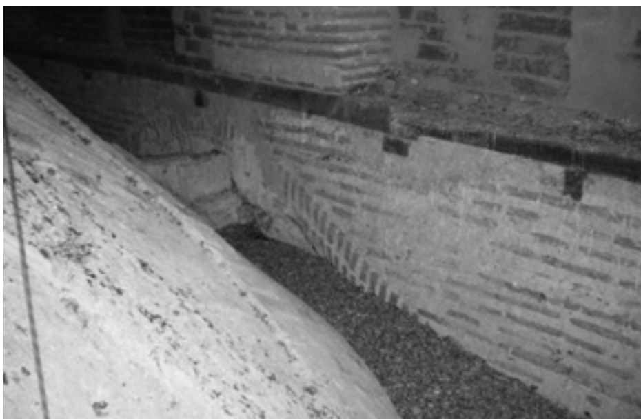
Fot. 3. Arquerías ciegas del crucero.
