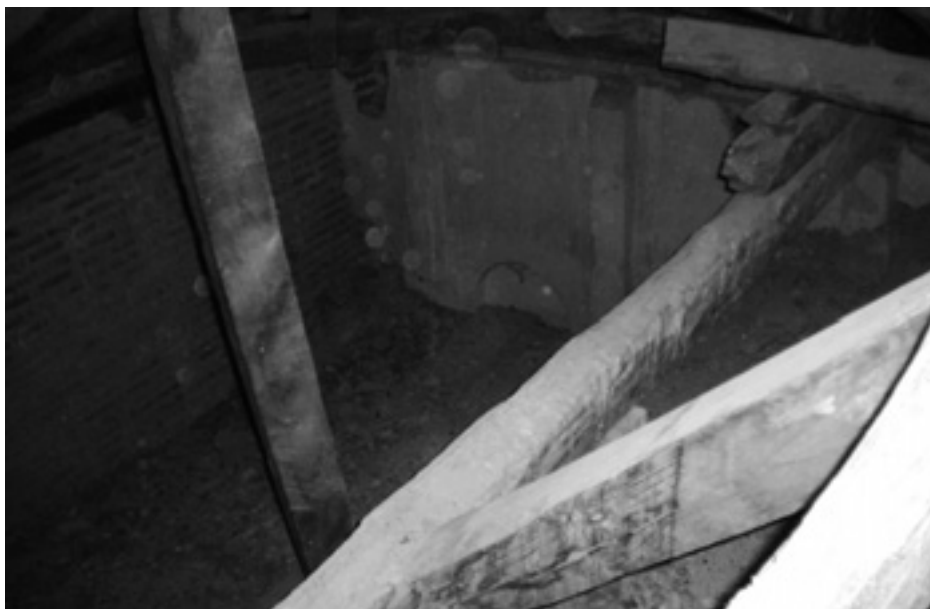
Fot. 4. Restos de los arcos torales del antiguo crucero.
