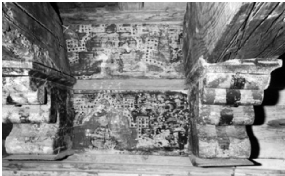
Foto 11. MORADILLO DE ROA (Burgos): ermita de Nuestra Señora de Ejido. Detalle del doble alicer de la armadura de parhilería de su única nave. Comienzos del siglo XV.
