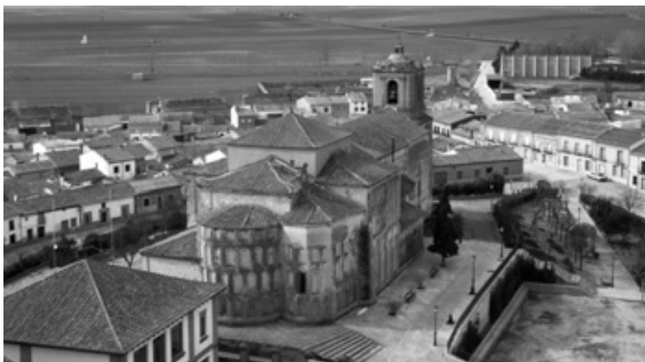
Fot. 1. Vista general.
