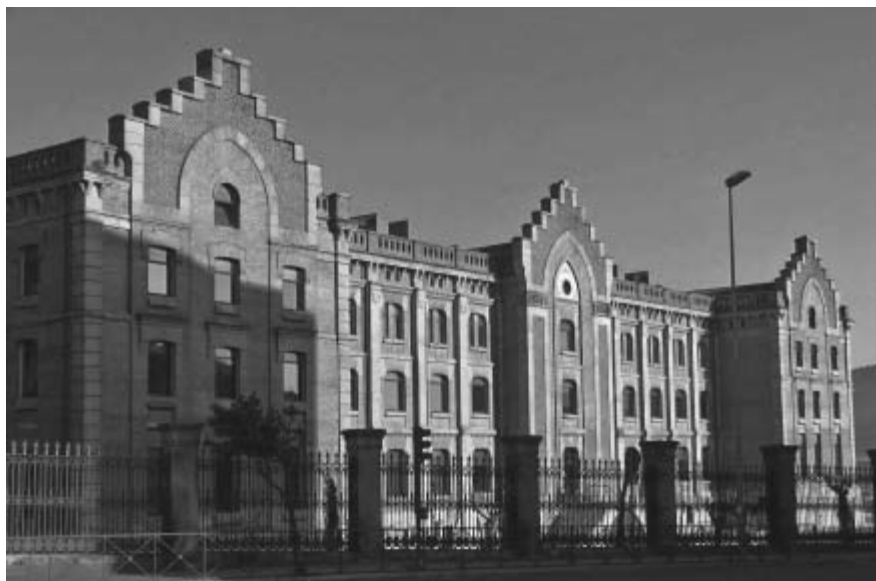
Fig. 3. Plasencia, Centro Universitario, antiguo colegio de San Calixto (J.M. González).
