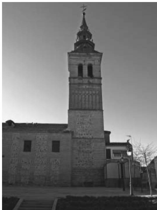
Fig. 2. Fachada norte de la torre de la iglesia parroquial de Navalcarnero, estado actual (autor).
