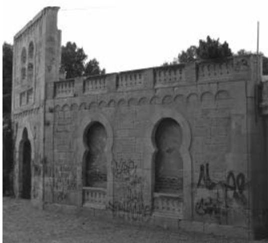
Fig. 4a. Restos de la antigua fachada reutilizados con un fin ornamental en el acceso a una cueva típica de la vivienda popular tradicional en Crevillente (autor).
