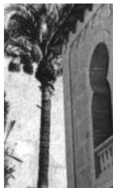
Fig. 3b. Detalle de la decoración tallada en cantería y las ménsulas de madera que sobresalen a partir del sistema interno de vigas ( Revista Semana Santa , Crevillente, 1979).
