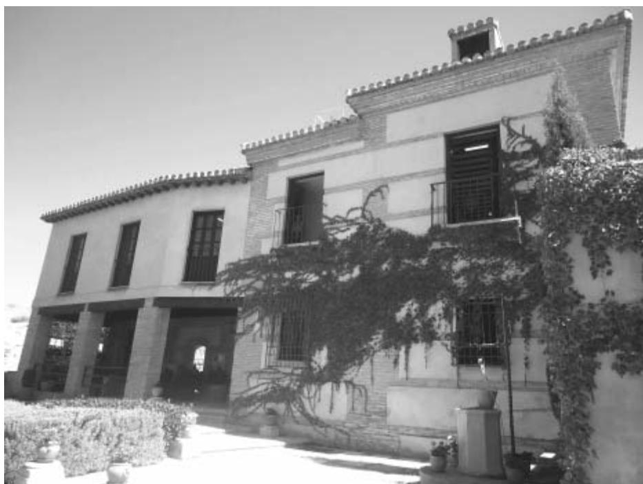
Fig. 3. Fachada occidental del inmueble hacia el jardín.
