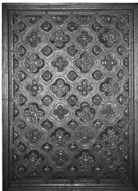
Fig. 17. Alfarje del acceso a la escalera.
