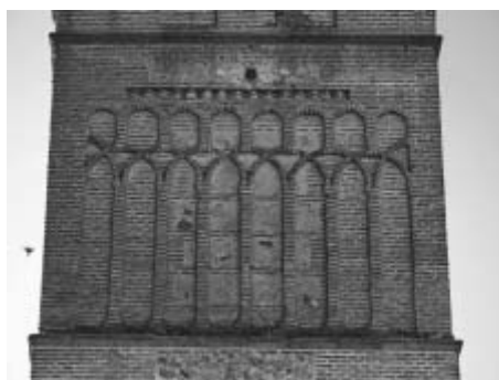
Fig. 4. Detalle del cuerpo decorativo de la torre, fachada norte (autor).
