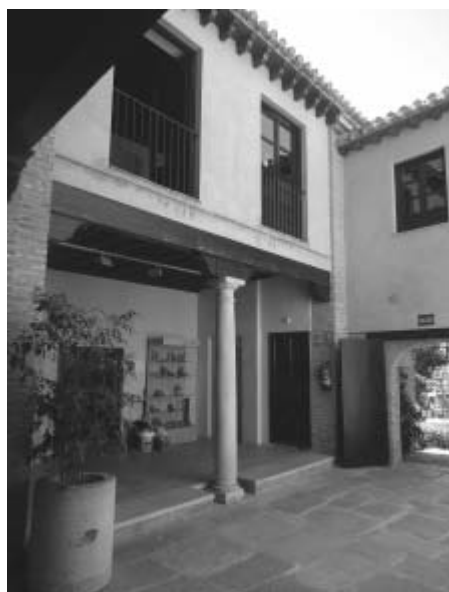
Fig. 6. Pórtico y galería meridional.
