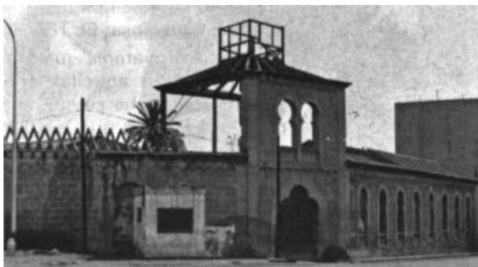
Fig. 3a. Proceso de demolición de la Casa de les Persianes. En la década de 1960 se construyó una báscula para el pesaje de camiones en el tramo noroeste, que ocultaba parte de un arco de herradura ( Revista Semana Santa , Crevillente, 1979).
