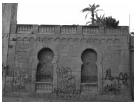
Fig. 5a. En su emplazamiento original, la fachada lateral contaba con dos hiladas de basamento de sillería; en el Parc Nou sólo se conserva una, dada la nula pendiente (autor).
