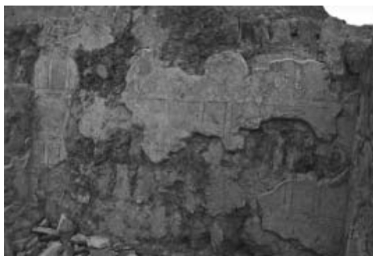
Fig. 4. Revestimiento del camino de ronda de Madinat al-Zahra (Córdoba).
