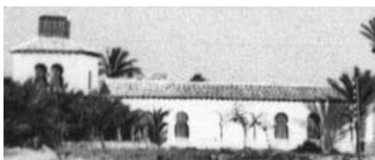
Fig. 2b. Ampliación de detalle realizada a partir de una fotografía paisajística de la Colección Agustín, en la que se aprecian, parcialmente, los elementos de carpintería: ventanales de madera tras los arcos de herradura, ménsulas, etc.
