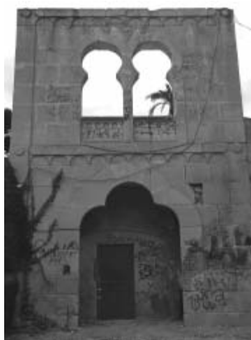
Fig. 4b. Detalle de la antigua puerta principal. Actualmente, a través de ella se accede a la cueva de propiedad municipal usada como almacén (autor).
