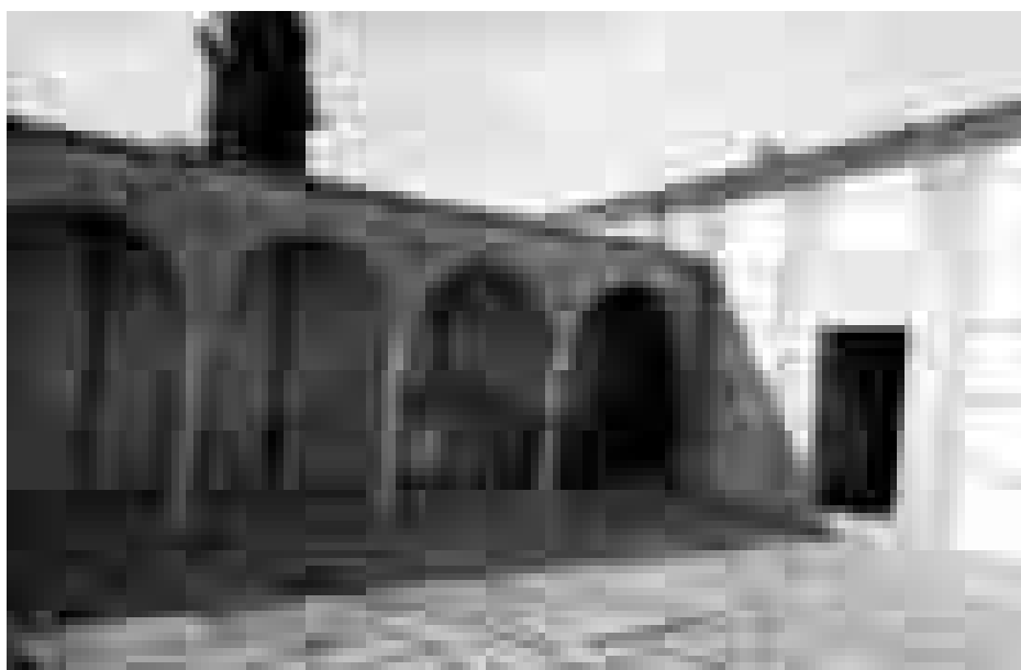
Foto 5. Técnicas constructivas: tapial (mezquita de Slouguia).
