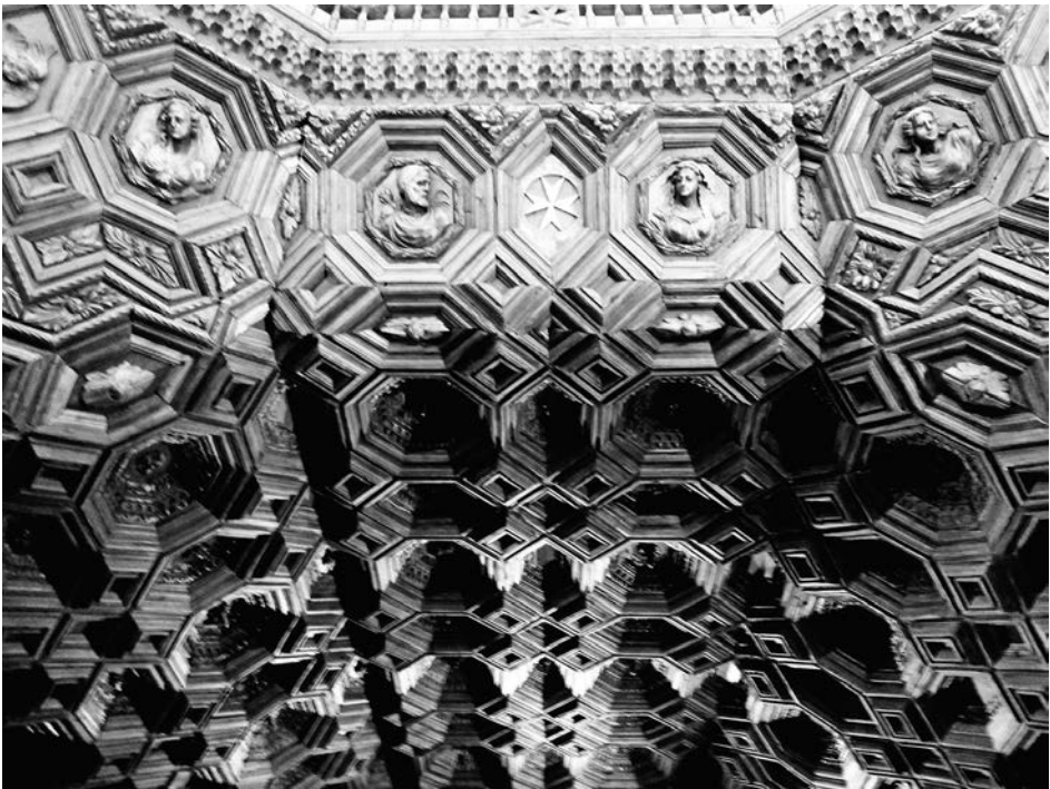
Fig. 13. Techumbre acasetonada renacentista del coro alto de madera en Villar de Fallaves, Zamora, hoy en el Museo Nacional de Escultura de Valladolid.
