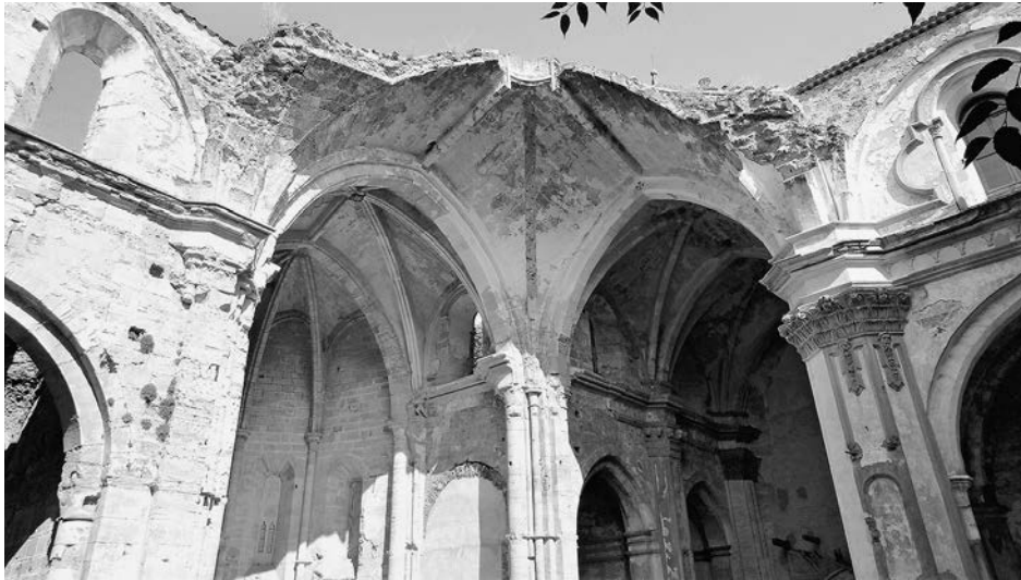
Fig. 4. Iglesia abacial de Santa María de Piedra, construida entre 1262 y 1350 siguiendo los modelos hispano-languedociano y del gótico burgalés, con bóvedas autoportantes, nervio en ligazón central y pilares de sección cruciforme y octogonal.
