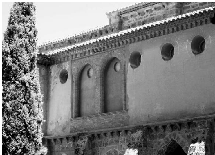
Fig. 10. Claustro superior construido en el monasterio de Piedra después de 1446 para articular a su alrededor las celdas individuales de los monjes.
