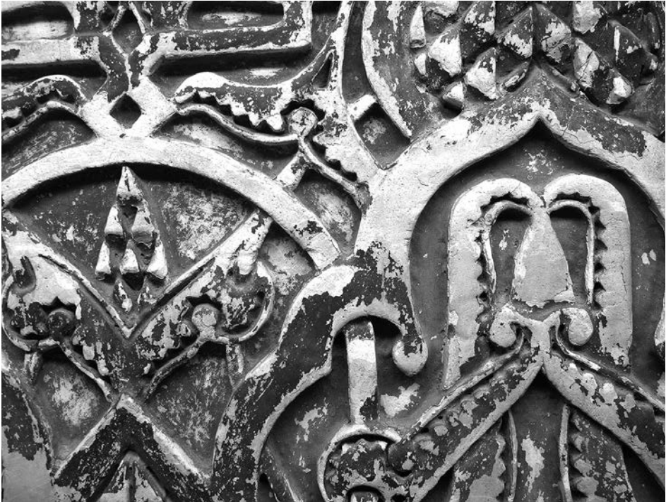
Fig. 6. Detalle del ataurique, donde se observa la piña que ha quedado sin tallar.
