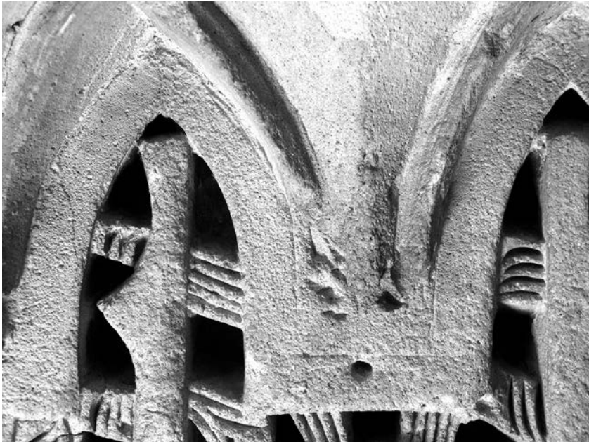
Fig. 11. Triscados para favorecer la adherencia entre capas de mortero.
