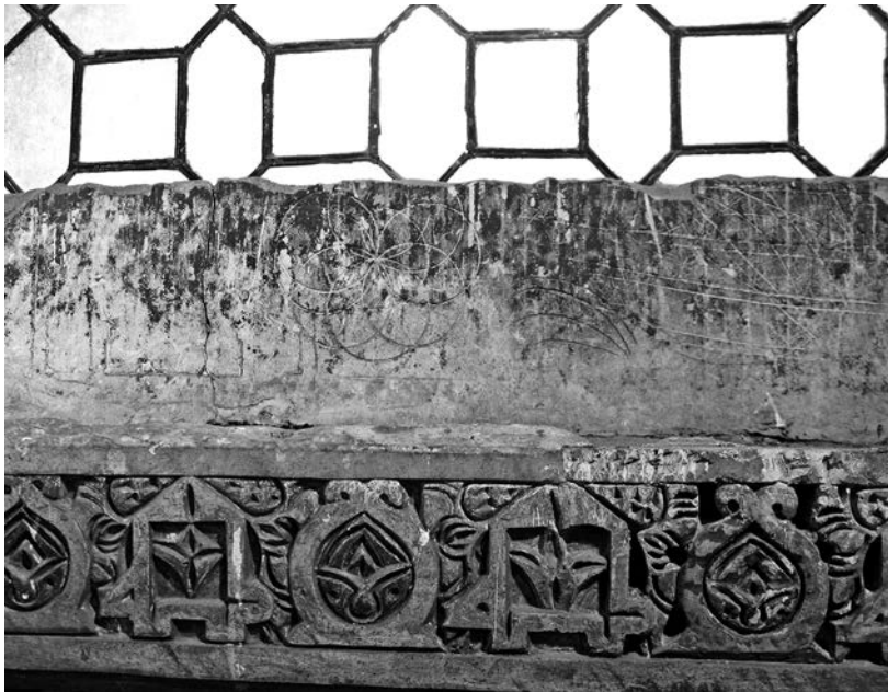
Fig. 9. Ensayos de diseños geométricos en una ventana del muro norte.
