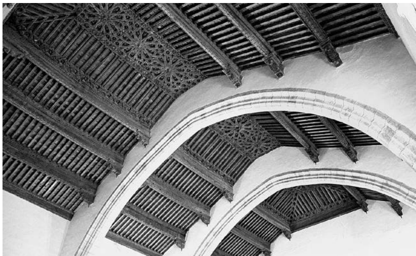
Fig. 1. Armadura de cubierta elaborada por el maestro de carpintería García de Luzaga entre 1567-1571 para la nave de la iglesia de San Andrés de Zamora (foto del autor).
