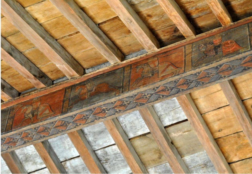
Detalle de la viga central.
