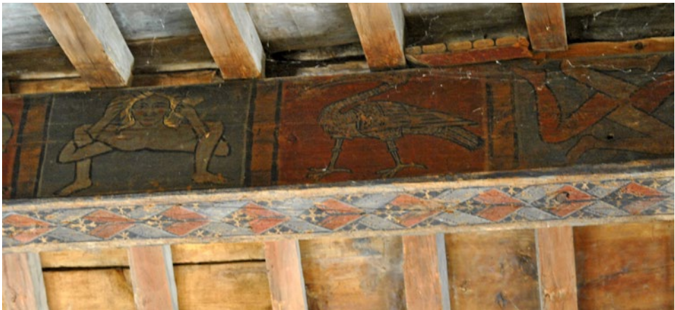
Otros tramos de la viga central.
