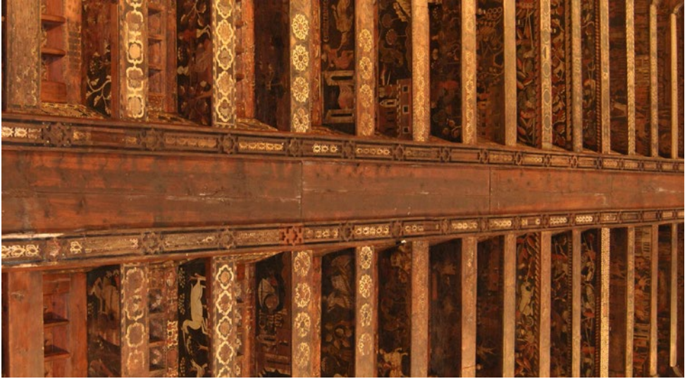
Viga central y laterales.
