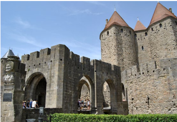
Carcasona. Muralla y puerta de entrada.
