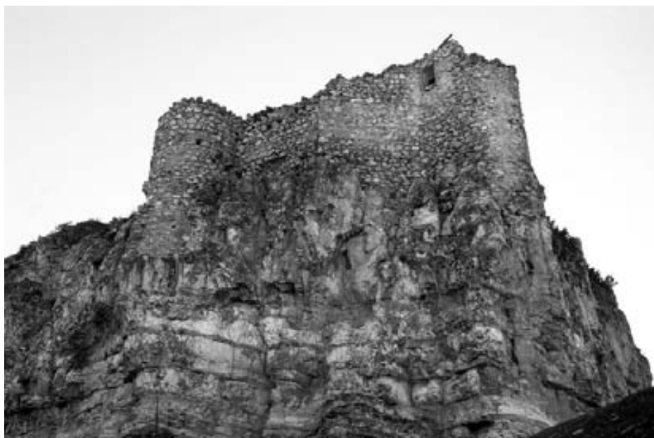
Fig. 14. Torres cilíndricas del castillo en su lado norte construidas con fábrica de yeso.
