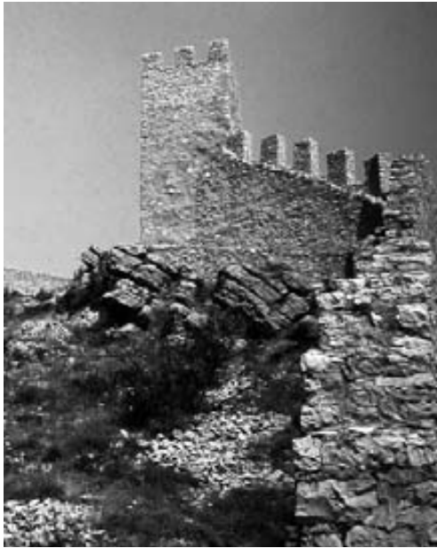
Fig. 4. La torre n.º 2 del lado oriental con las dos fases constructivas.
