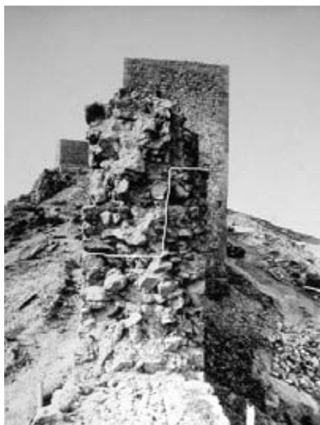
Fig. 7. Sección del lienzo entre las torres 4 y 5 en donde se aprecia el camino de ronda antiguo con su peto (remarcados en la foto).
