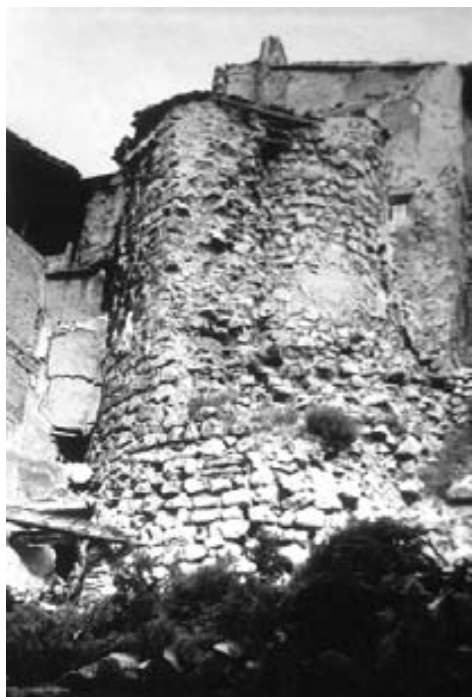
Fig. 13. Torre cilíndrica de la muralla de la Engarrada antes de su restauración, mostrando el núcleo original, seguramente de yeso.
