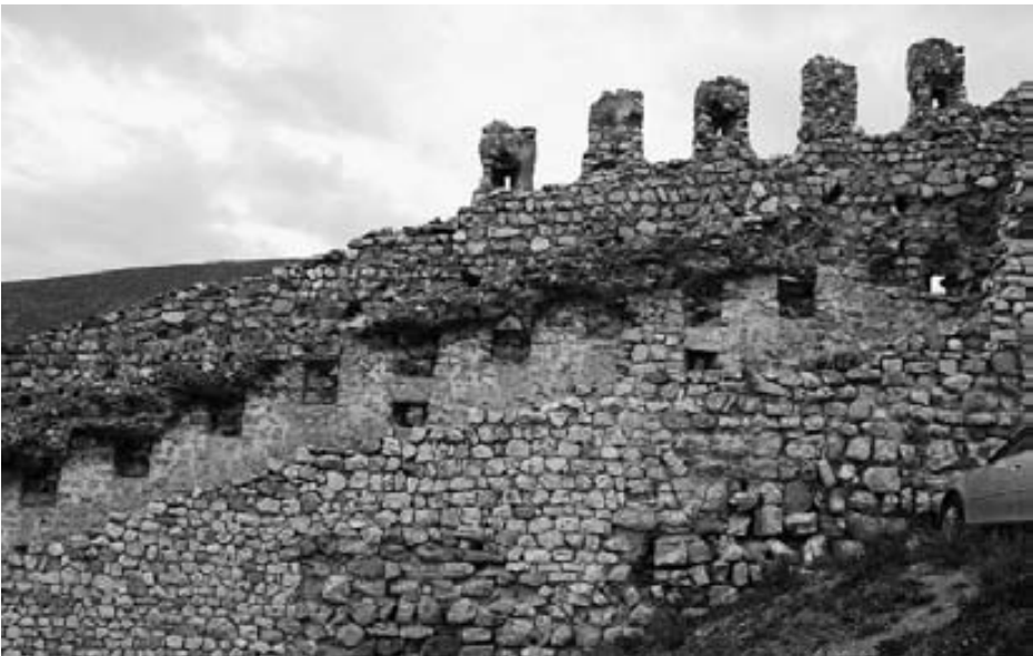
Fig. 6. El lienzo entre las torres 11 y 12 visto desde intramuros mostrando los dos caminos de ronda con sus almenas correspondientes.
