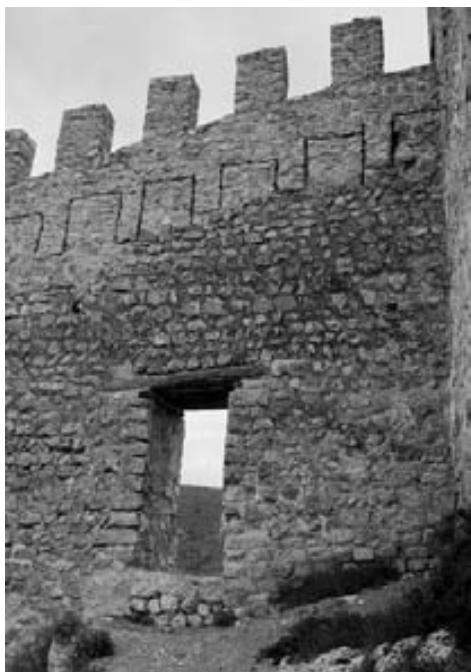
Fig. 11. Portillo de la muralla junto a la torre n.º 5 en donde se extrajeron las muestras para datación por dendrocronología.
