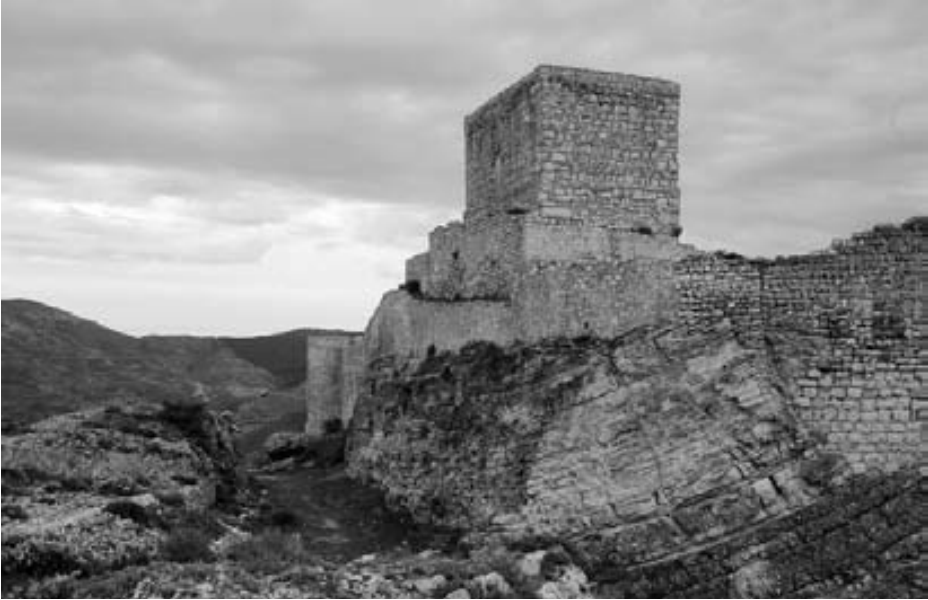
Fig. 3. La Torre del Andador con sus sucesivos forros de refuerzo.
