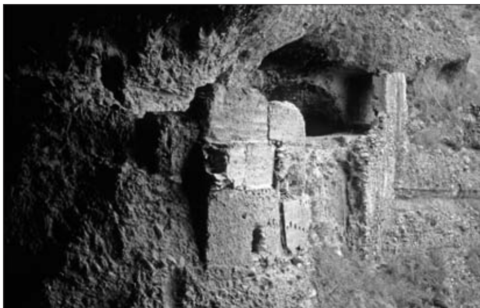
Fig. 9. Pared de tapial de la dependencia superior de la cueva-castillo de Los Fayos.
