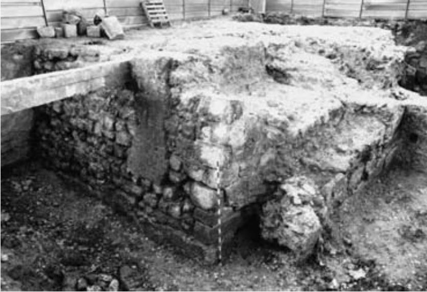
Fig. 15. Vista general de algunas de las estructuras que formaban el conjunto del Portal de Zaragoza, antes de iniciarse las labores de “saneamiento”. La fig. 9 es un plano de síntesis del conjunto.
