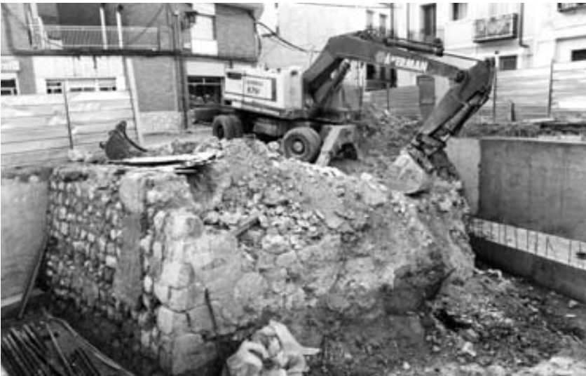
Fig. 16. Proceso de demolición del Portal de Zaragoza: la pala excavadora se tuvo que emplear a fondo para realizar el peculiar “saneamiento de la estructura”. Por la posición de la pala, en el momento de la fotografía estaba eliminando la muralla del siglo XIII y el torreón de 1347.
