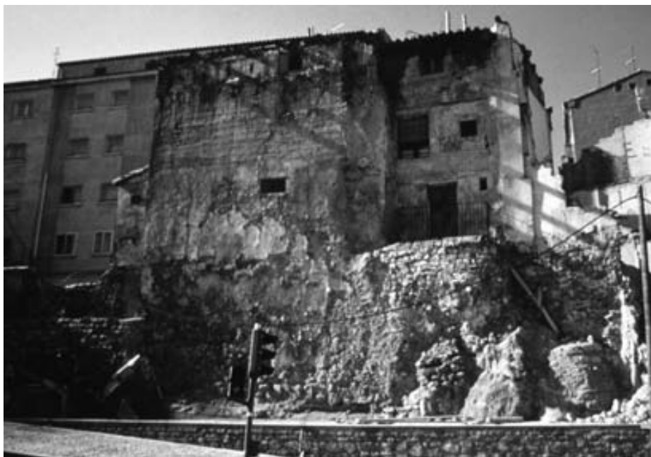
Fig. 18. Lienzo de muralla de Ronda Miguel Ibáñez, antes de la demolición. Salvo el remate de aspilleras, realizado en los años 40 del siglo XIX, el resto de la estructura era bajomedieval.
