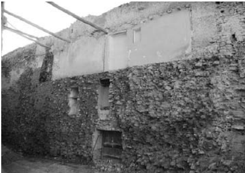
Fig. 10. Vista del tramo de muralla medieval descubierto en Ráfales. La muralla se construyó en su interior con un relleno de mampuestos de arenisca trabados con barro.
