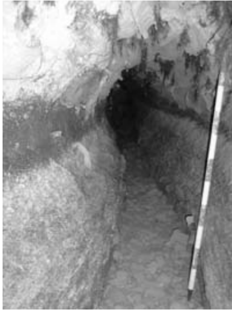
Fig. 5. Aspecto de un tramo de la obra original de la Acequia nueva recientemente descubierto en la zona de los Muros de Castelserás.
