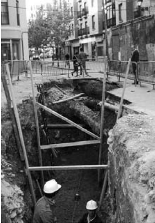
Fig. 27. Zanja abierta en la C/ Mayor para la renovación de infraestructuras.
