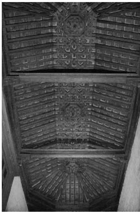
Fig. 4. Salamanca. Iglesia del antiguo colegio de la Caridad. Armadura de la nave.
