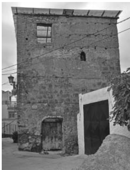
Fig. 1. Torre del Tío Vayo (Albuñuelas).
