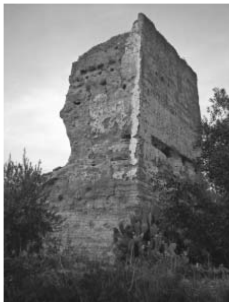
Fig. 2. Fuerte de Márgena (Dúrcal).
