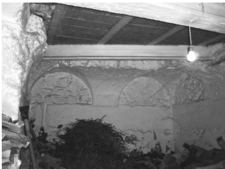
Fig. 3. Interior de la torre de Restábal (posible aljibe).
